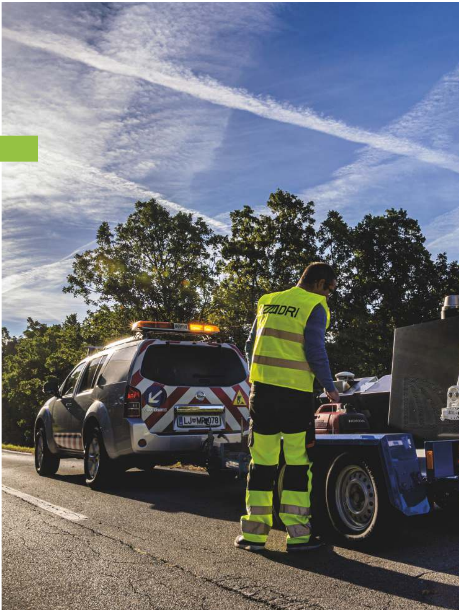
/ MERITVE NOSILNOSTI VOZIŠČNIH KONSTRUKCIJ /
