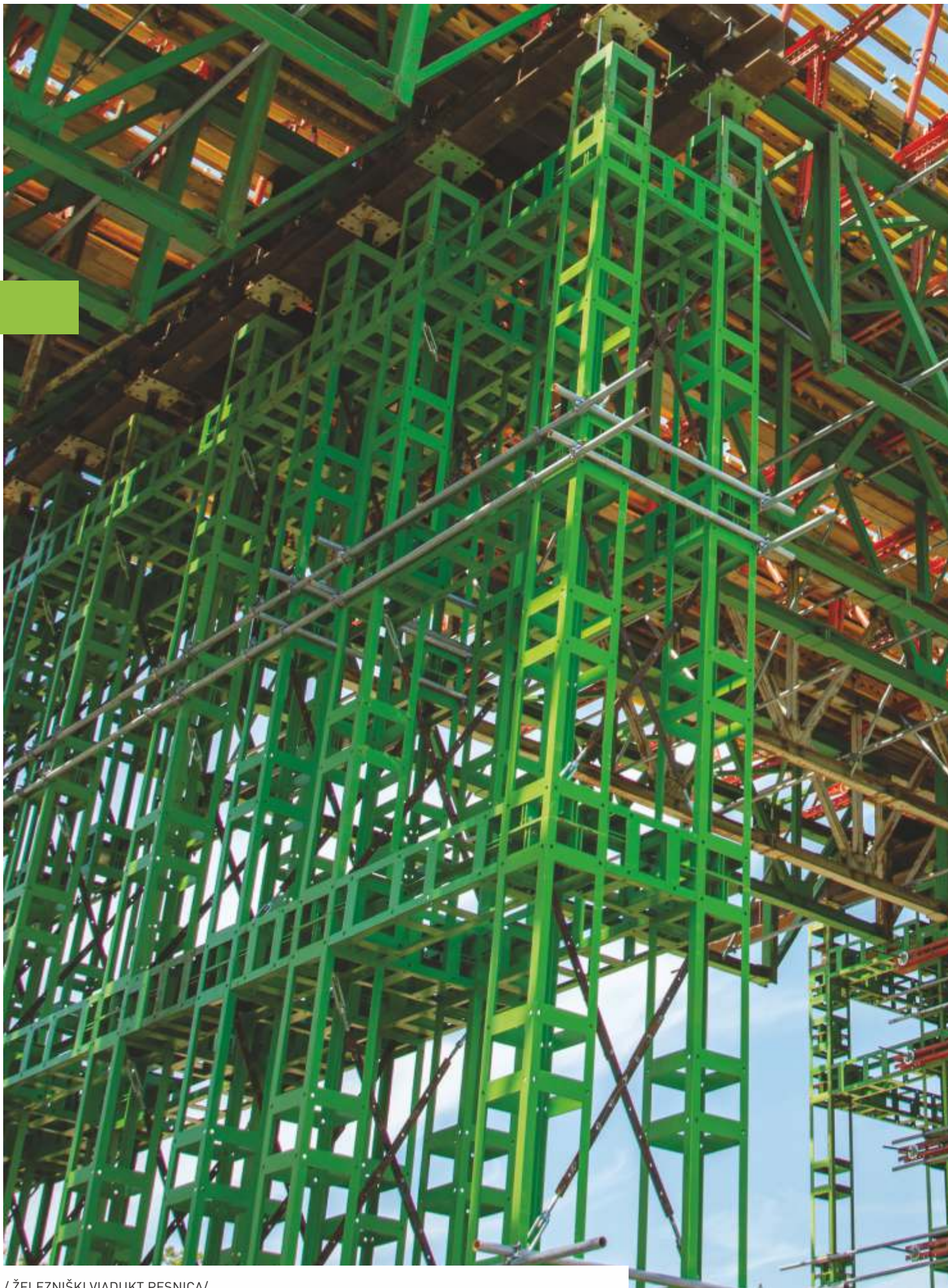
/ ŽELEZNIŠKI VIADUKT PESNICA/
