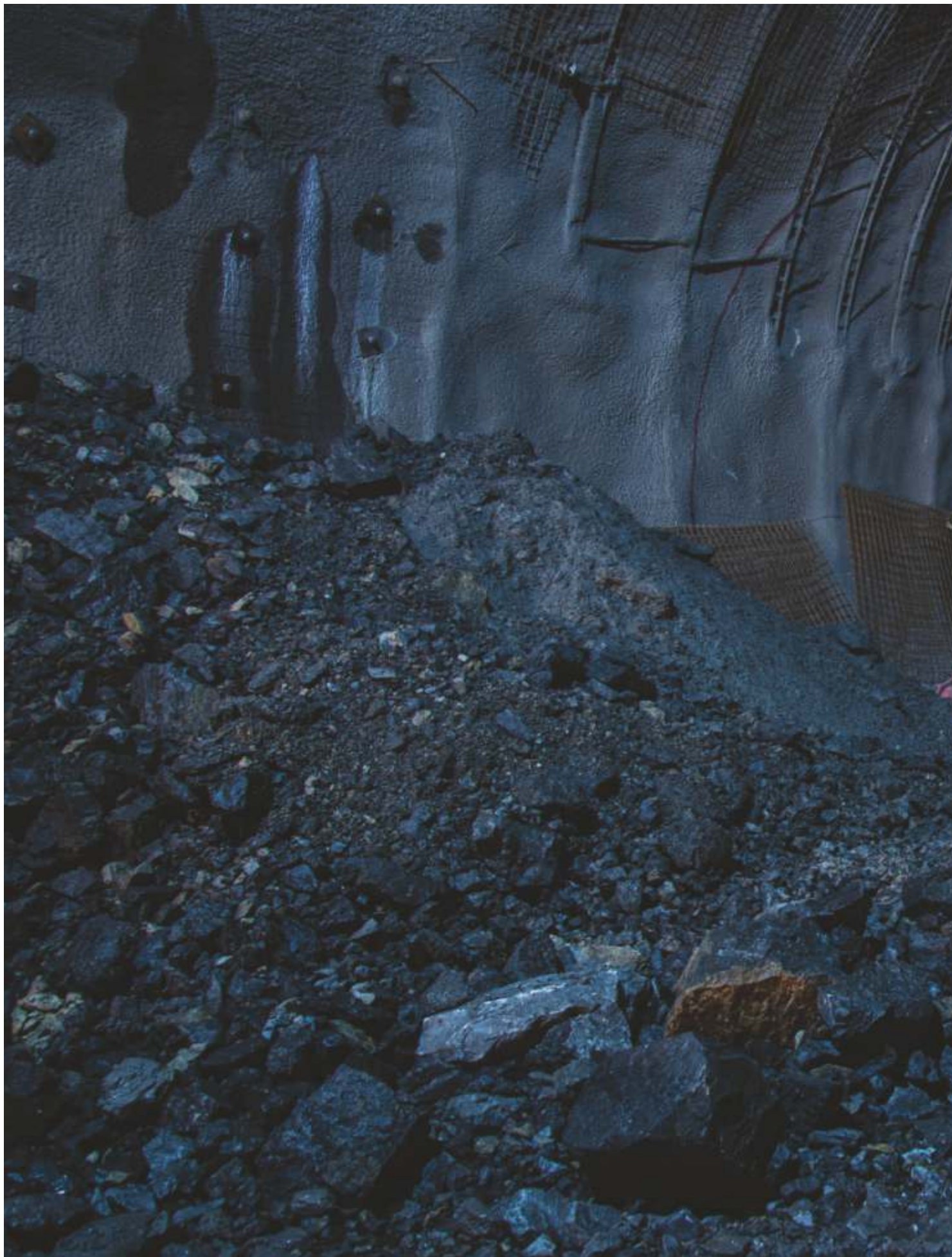
/ GRADNJA PREDORA NA DRUGEM TIRU ŽELEZNIŠKE PROGE DIVAČA-KOPER /
